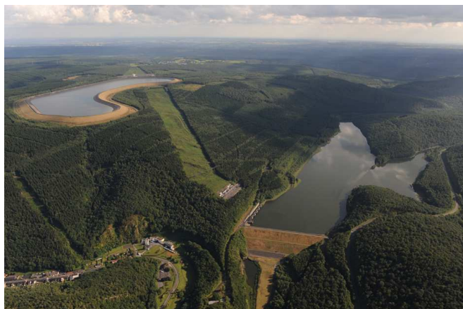
Figure 11 : Photo des réservoirs de la S.T.E.P. de Revin
